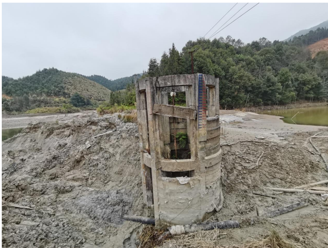
图 2-6 排水井（整改前）
