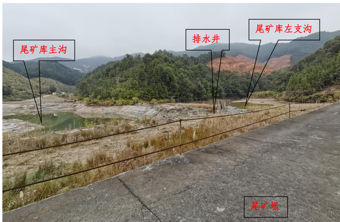
图 2-3 尾矿库闭库前（坝上看向库尾）
