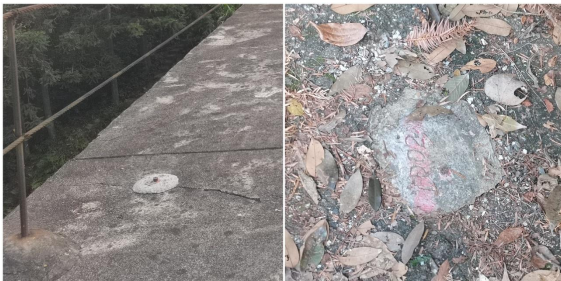
图 2-8 坝顶位移观测点和坝肩观测基点
