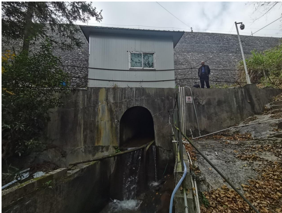
图 2-7 排水涵洞出口
