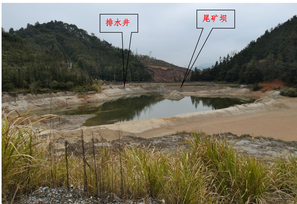
图 2-2 尾矿库整改前（库尾看向坝前）
